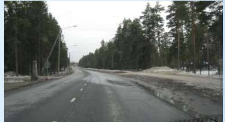
Kuva. Sulamisvesiä tutkimuskohteessa 13. huhtikuuta 2011
